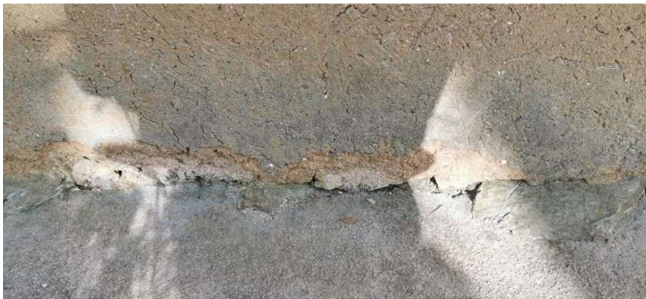
⑨旧河野家住宅（西面） 基礎部分の拡大写真
